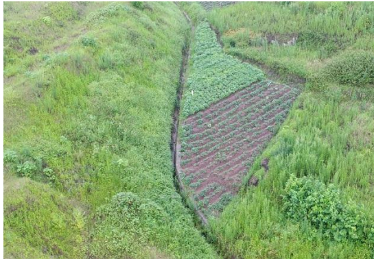
已修建排水沟现状
