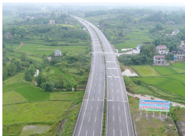
路基工程区景观绿化及排水
