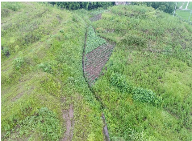
渣场排水沟及绿化
