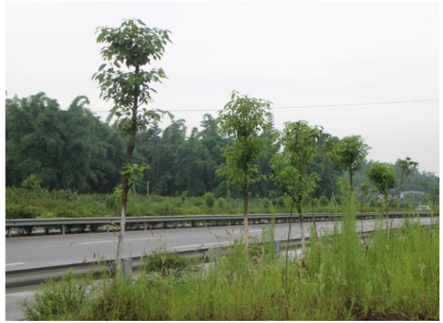
路基工程区景观绿化
