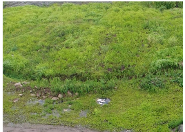
预制场恢复情况
