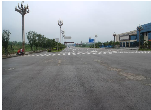
路基工程区景观绿化
