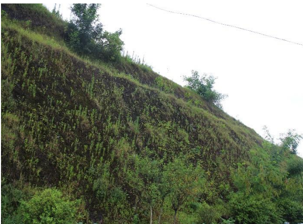
路基工程区边坡绿化
