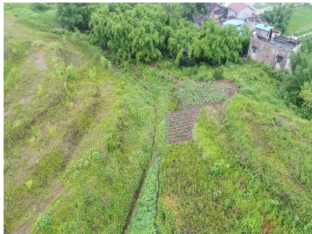
渣场排水沟及绿化
