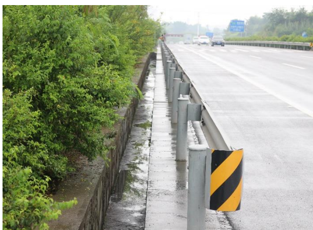
路基工程区排水沟
