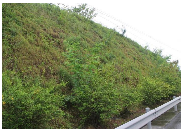
路基工程区景观绿化及排水
